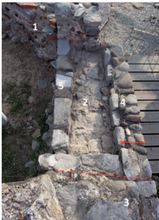
Fig. 25. San Giovanni Evangelista, angolata di nord est. Al battistero (1) si addossa il perimetrale della chiesa (2), che presenta un pilastro di accesso al corridoio (3). Posteriore è il loculo (murature 4 e 5, restaurate nella parte alta).
