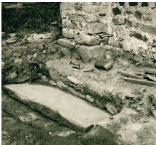
Fig. 22. San Giovanni Evangelista, fondazione dell'angolata sud-ovest ricostruita in parte su una lastra tombale (scavo del 1968 di Alessandro Deiana).
