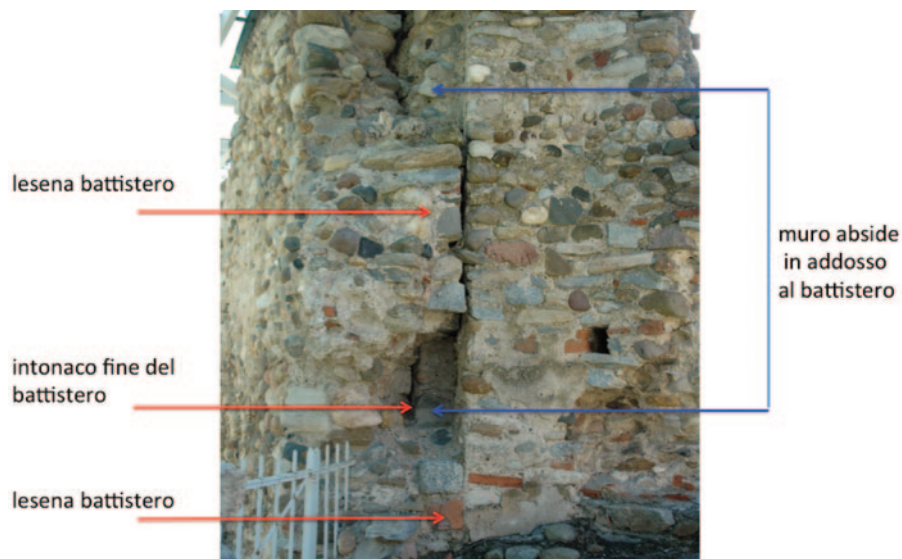
Fig. 11. Relazione stratigrafica tra chiesa e battistero (a nord). Il muro dell'abside, dopo un primo tratto circolare, diviene rettilineo addossandosi al perimetrale ovest del battistero (intonacato e con una lesena).
