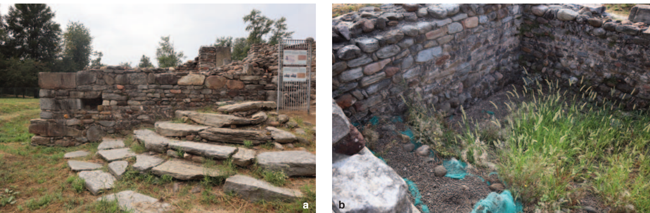
Fig. 4. Torre-campanile: a. esterno est con elementi lapidei reimpiegati; b. paramenti interni in ciottoli.
