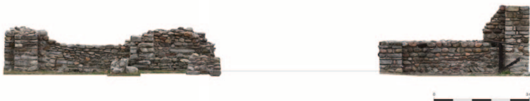
Fig. 23. San Giovanni Evangelista, facciata ricostruita (in parte con i restauri).
