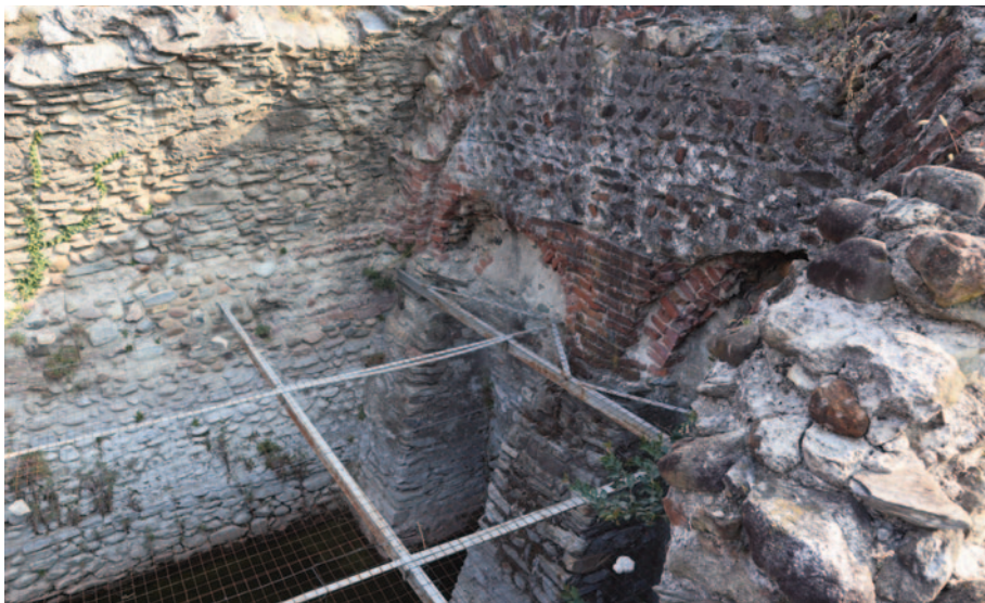
Fig. 29. Cisterna, lato est: contrafforti in addosso a sostegno di due archi in laterizi sui quali si impostano una muratura a spinapesce (in ciottoli con alcuni laterizi) e la rifoderatura della volta in laterizi.
