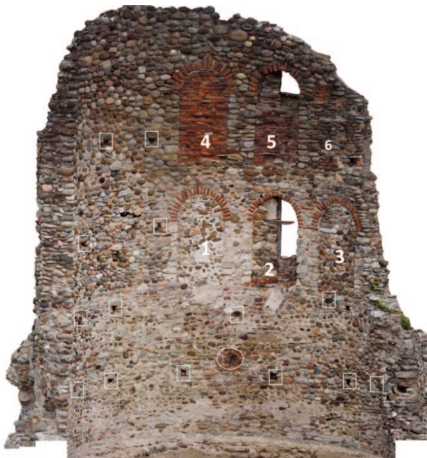
Fig. 15. San Giovanni Evangelista, abside maggiore: prospetto interno con finestre tamponate (1-6), fori pontai nei rettangoli e un taglio nel cerchio.
