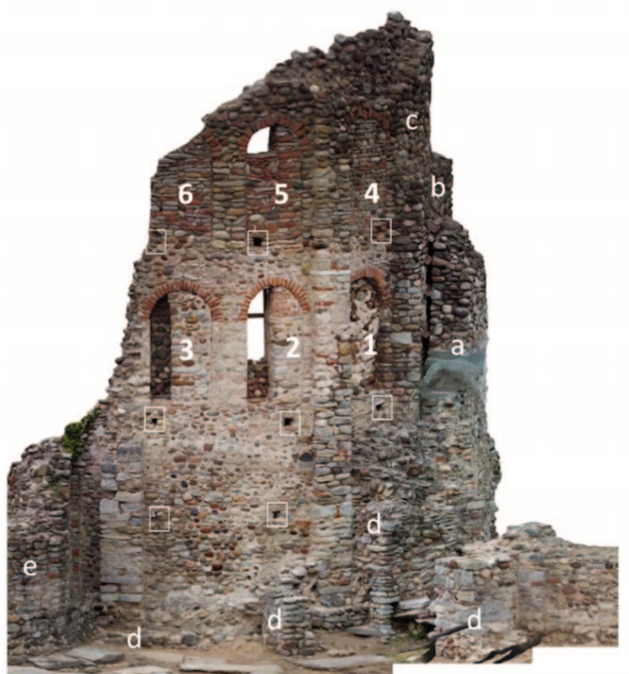
Fig. 16. San Giovanni Evangelista, prospetto esterno. Al perimetrale del battistero (a) si addossa il tratto rettilineo dell'abside (b), sovrastato da quello semicircolare (c). Posteriori sono i contrafforti (d) e l'abside minore (e).
