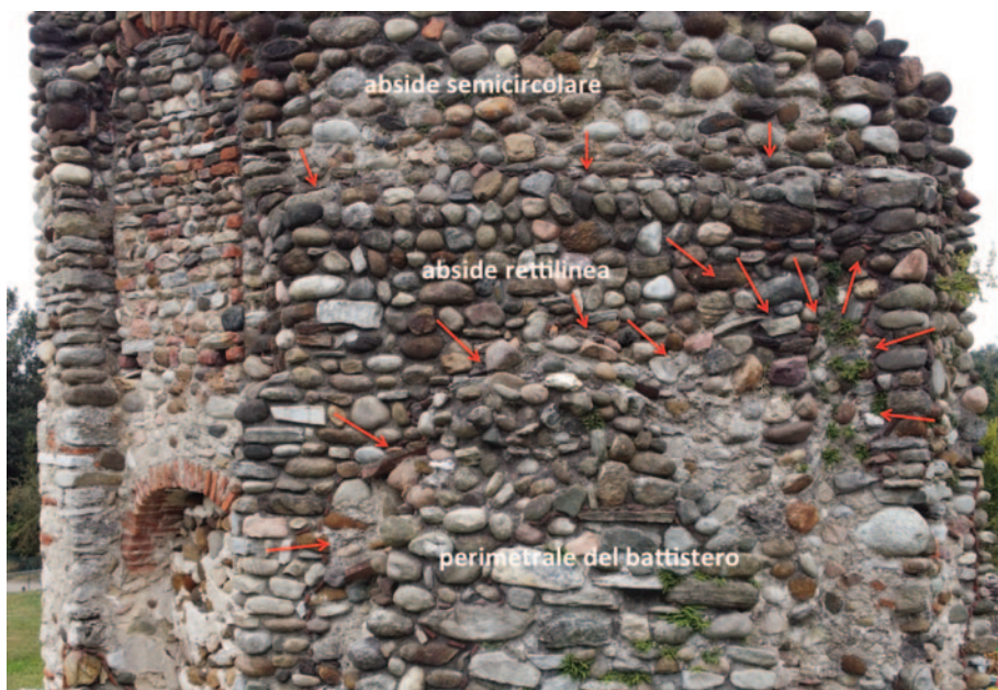
Fig. 10. Tratto rettilineo dell'abside della basilica addossata al perimetrale del battistero; al di sopra dell'addosso, l'abside ritorna circolare.
