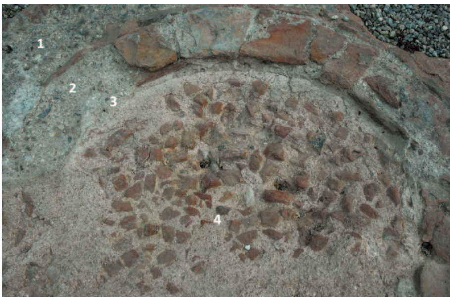
Fig. 8. Battistero, vasca circolare: 1. anello esterno in frammenti di tegole poste radialmente per lo più di taglio; 2. anello interno in frammenti di tegole in piano; 3. strato di intonaco fine di colore nocciola; 4. strato di malta idraulica e grossi frammenti di laterizi.
