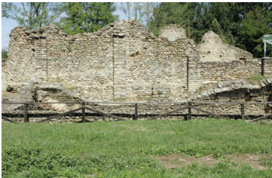
Fig. 19. San Giovanni Evangelista, perimetrale sud.
