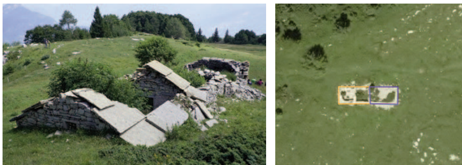
Fig. 10. Il baito 5002 di Malga Comunal. A sinistra, vista del baito da NW; a destra, vista zenitale della struttura, con evidenziate le due fasi costruttive principali.
