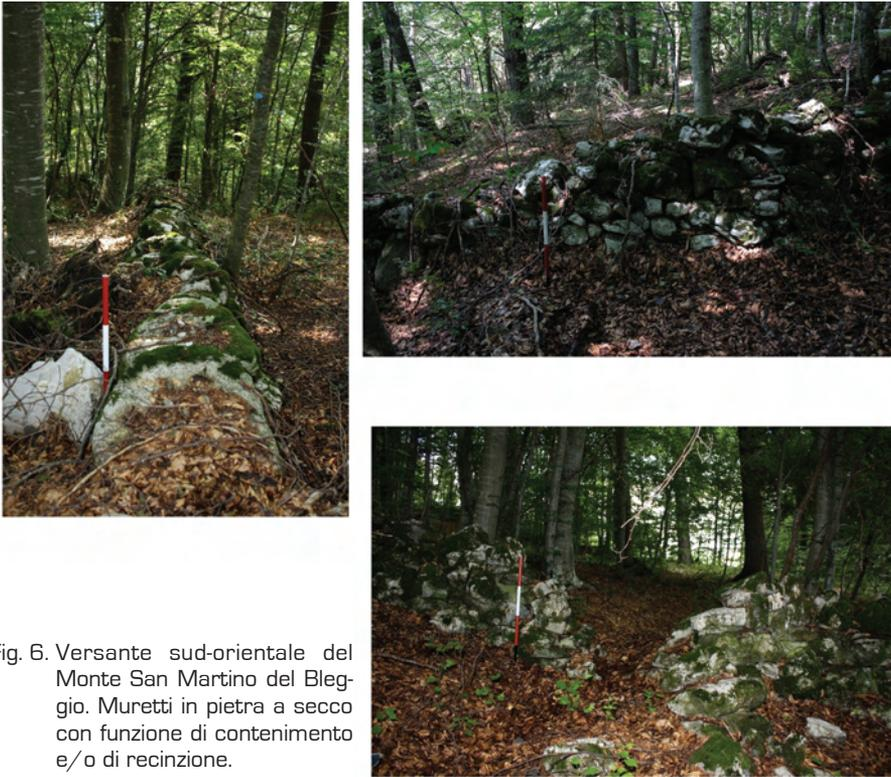
Fig. 6. Versante sud-orientale del Monte San Martino del Bleggio. Muretti in pietra a secco con funzione di contenimento e/o di recinzione.
