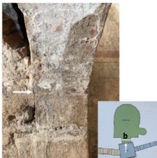
Fig. 22. Atrio, rapporto stratigrafico nello stipite dell'arcata nord.
