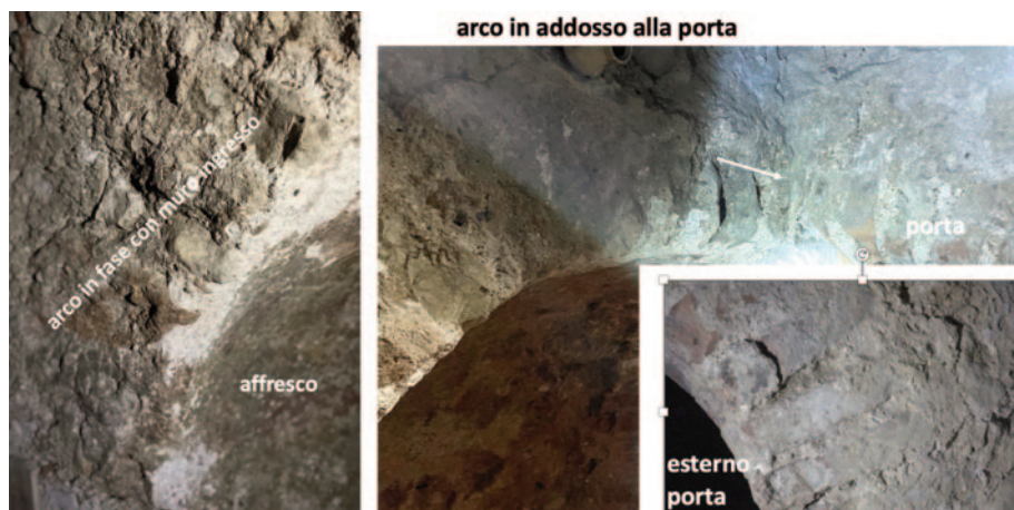
Fig. 17. Foto dell'ingresso nell'aula sud. Da sinistra: arco del muro curvo a nord con l'intonaco biancastro che risvolta sul perimetrale della scala ed è coperto dall'affresco; arco del muro curvo che si addossa al perimetrale ovest dell'aula; esterno dell'arco della porta in fase con il perimetrale dell'aula.
