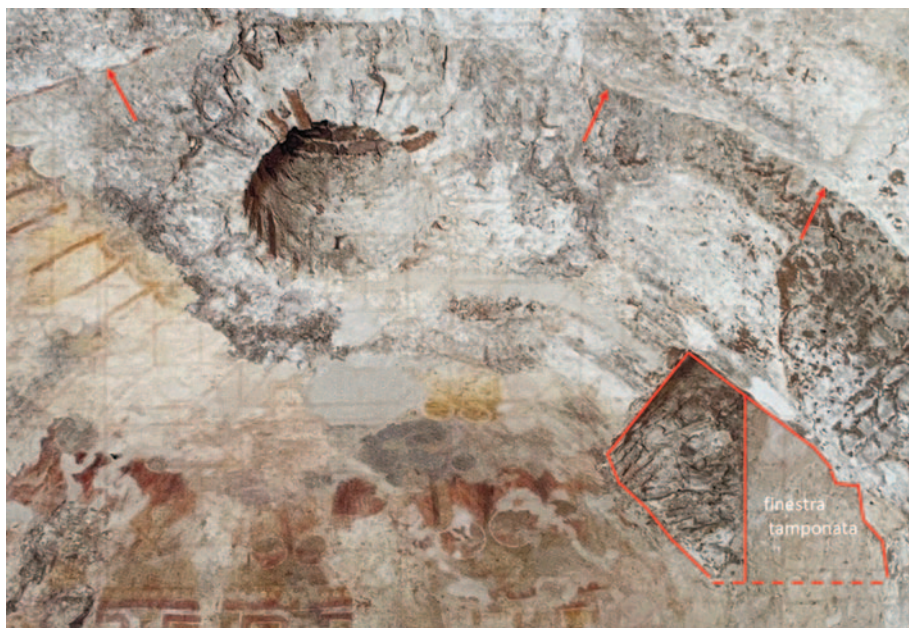
Fig. 24. Aula sud, addosso del catino absidale all'arcata e finestra tamponata (sulla destra).
