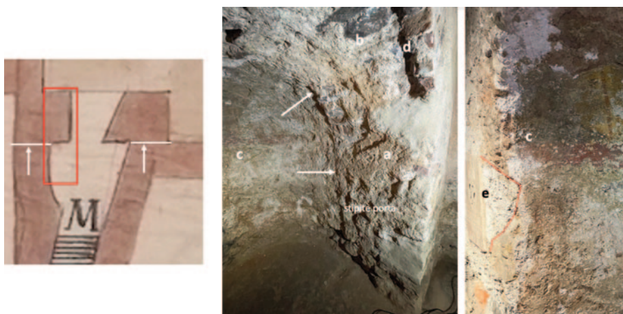
Fig. 18. Ingresso nell'aula sud: a. stipite della porta nel perimetrale ovest dell'aula meridionale; b. sottarco; c. muro curvo affrescato in addosso al perimetrale; d. particolare di un taglio nel sottarco della porta; e. taglio per inserimento dell'epigrafe che ricorda l'ampliamento predisposto da Girolamo Murari nel 1585.
