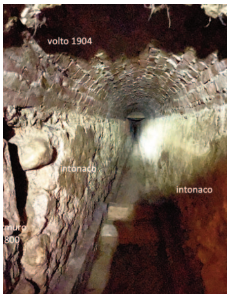
Fig. 12. Cunicolo dell'acquedotto, a valle dell'ingresso attuale, con il volto in mattoni costruito nel 1904.
